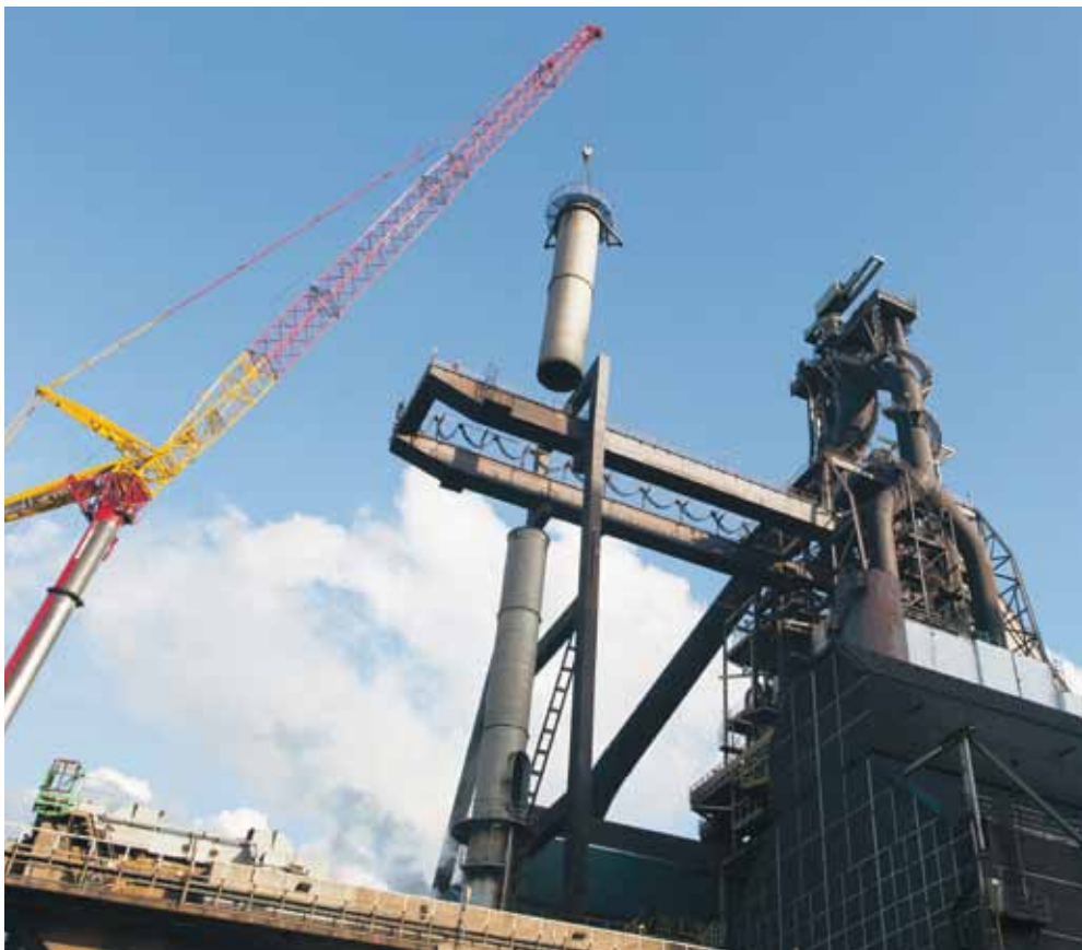
Het verwijderen van de schoorsteen bij Hoogoven 7
